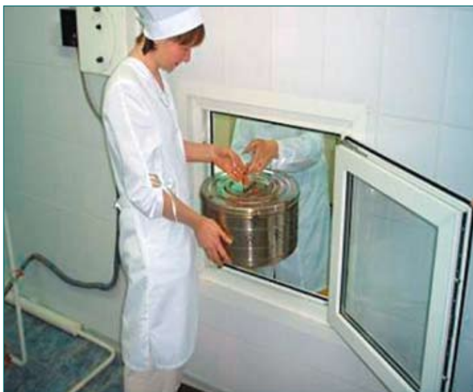
Рис. 2 Окно для передачи материала из «заразной» зоны в «чистую»
