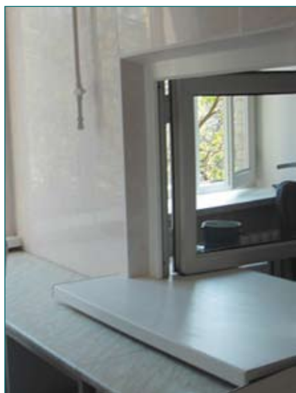
Рис. 2 Окно для передачи материала из «заразной» зоны в «чистую»
